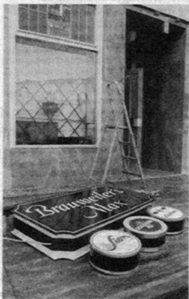
Noch ist „Max“ nicht fertig: An der Fassade wird noch gearbeitet.
